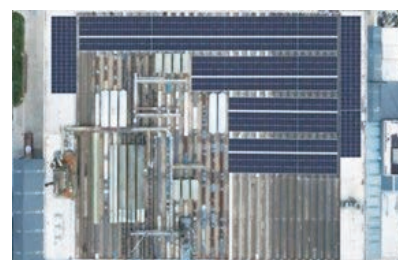
安裝光伏後的廠區屋頂
